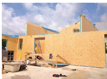
Eine Woche Bauzeit ab OK Kellerdecke bis zum geschlossenen Dach
